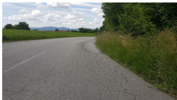
Slika 5: Nepregleden, nevaren ovinek s posedanjem roba cestišča in nepokoš. travo (avtor: M. Ančimer)
